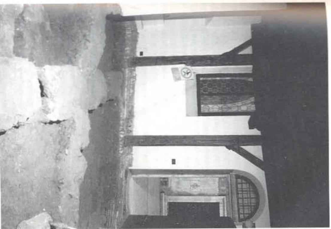
Castel Sant'Angelo, Armeria, stanza n. 1, a destra uscendo dalla rampa diametricale. Rinvenimento di muri intersecati trasversalmente da una conduttura d'acqua con pendenza verso il cortile (ottobre 1993).
