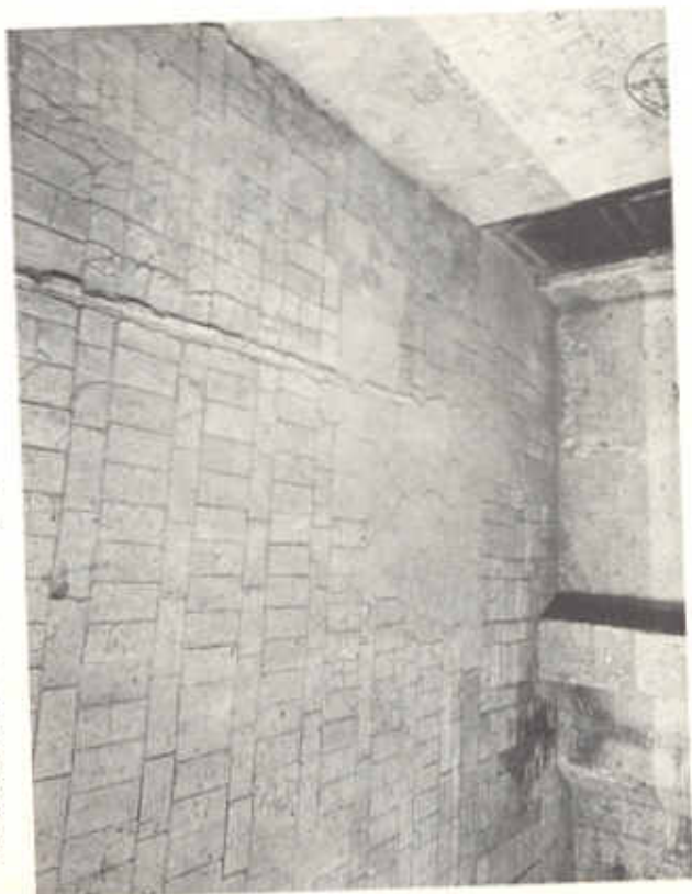
Fig. 6 - Traccia di un tramezzo « in foglio » pertinente all'appartamento della famiglia Goretti.
