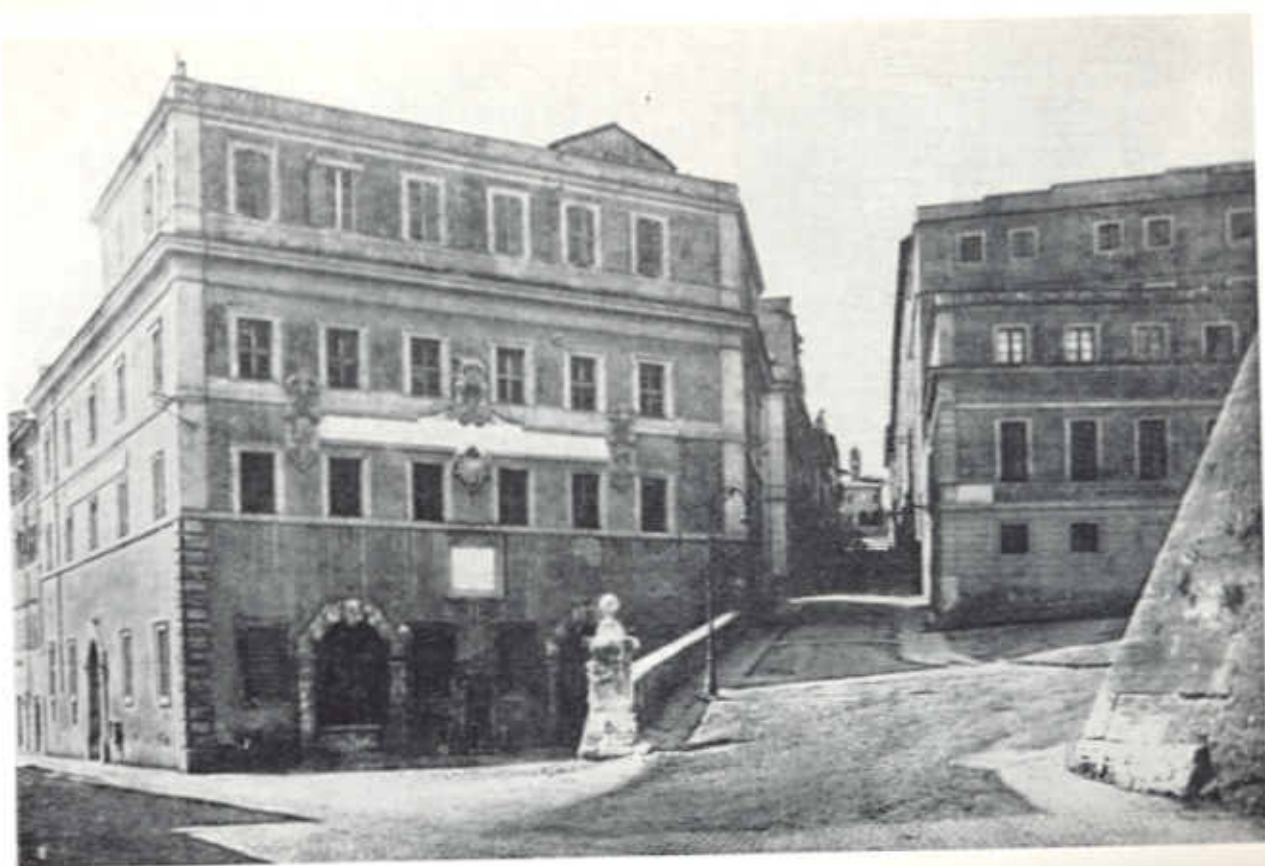
Resti di S. Onofrio, su via della Lungara prima della demolizione.
